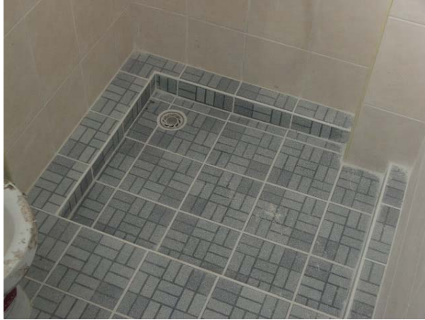
รูปที่ 4 การไม่ลดระดับหลังคาน ทำให้เห็นขอบคาน ซึ่งผิดจากวัตถุประสงค์ของแบบสถาปัตยกรรม
