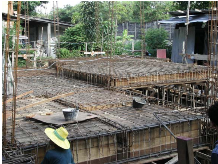
รูปที่ 5 แสดงลักษณะ โครงสร้างของบ้านที่มีการต่างระดับพื้นหลายระดับสอดคล้องกับที่แบบกำหนด
